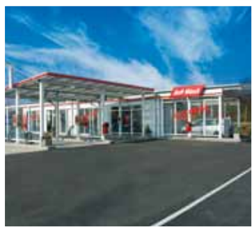
Tankstelle in Geilenkirchen
